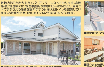
■法要や会食が行え、車イス用トイレも完備の管理棟。
