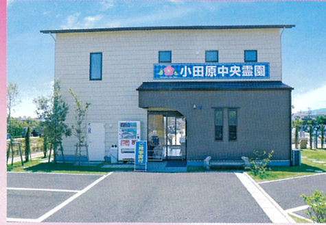
エレベーター付2階建ての管理棟
