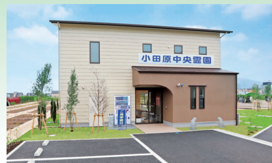
エレベーター付2階建ての管理棟
