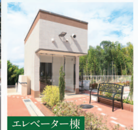
エレベーター棟
