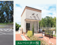
エレベーター棟
