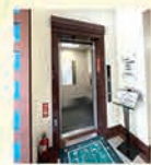
●エレベーター
